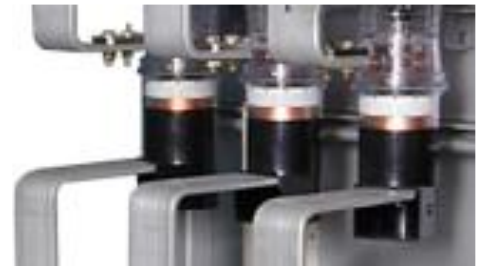
Рис. 28. Додаткова ізоляція полюсів ВВ, встановлених на ВЕ
