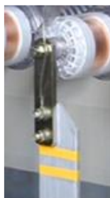
Рис. 7. Правильне встановлення зовнішніх шин
