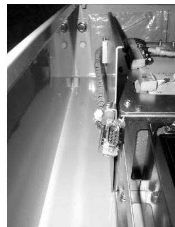
Место под установку дополнительного оборудования
