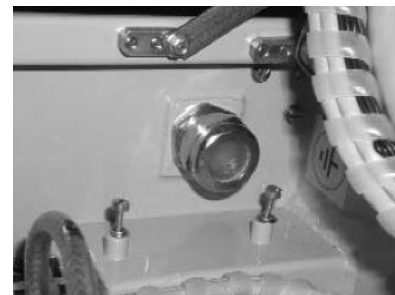
Отверстие под кабели коммуникаций
