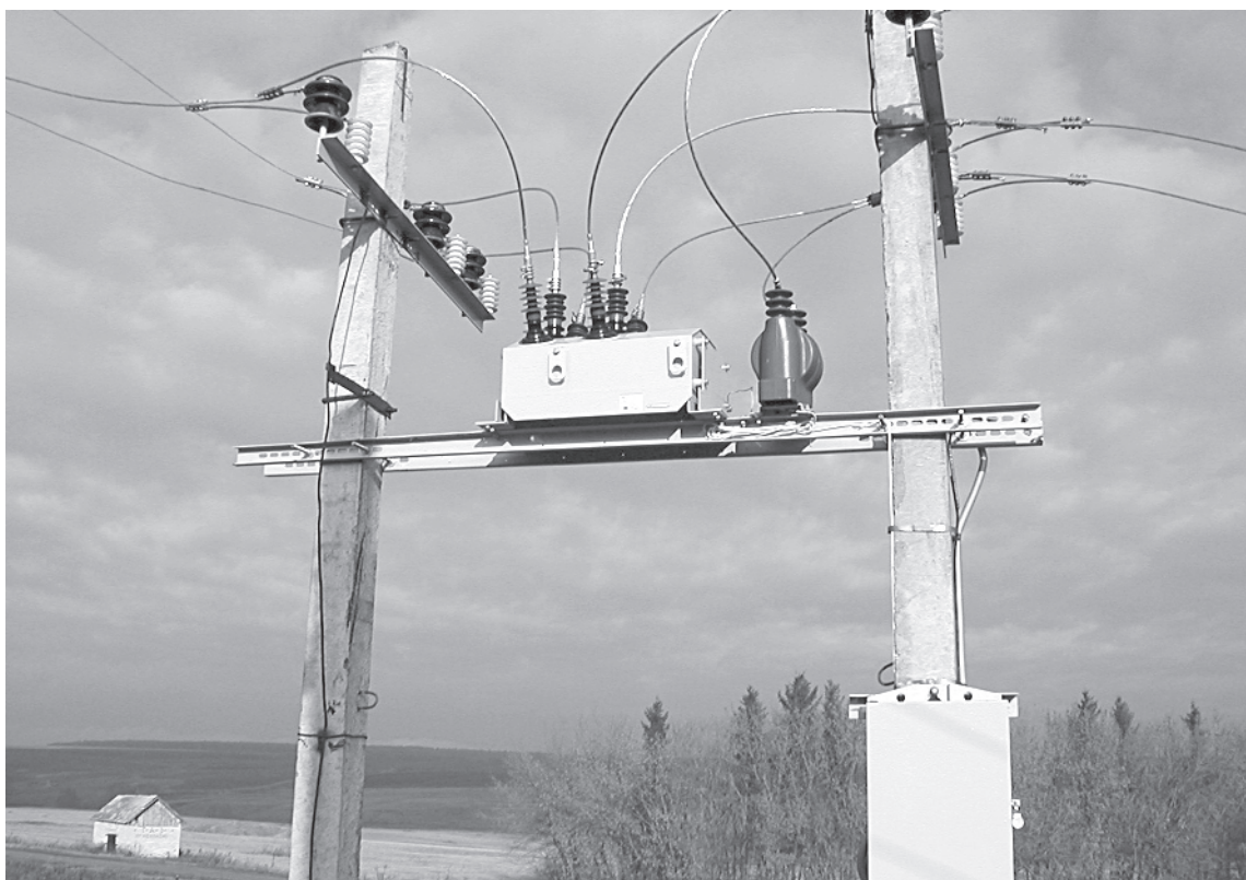
РВА\TEL-10 в качестве защитного аппарата фидера 10 кВ
