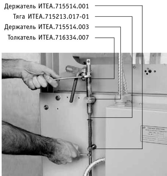
Рис. 14.12 Настройка и фиксация узлов и деталей блокировки
