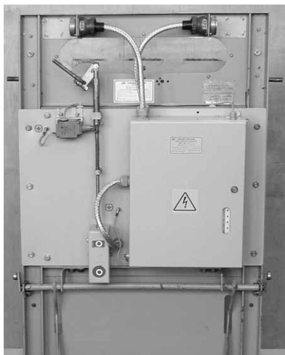
Рис.15.2 Внешний вид модернизированного ВЭ МВ АК/10/400/8 и АК 10/800/20
