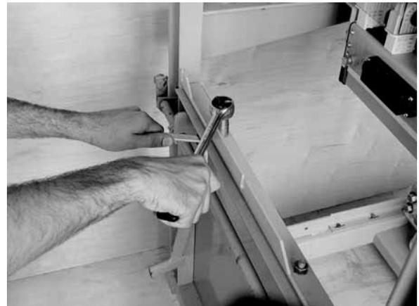
Рис.7.10 Установка стоек крепления фасадной панели для ВЭ МВ АК 10/2000/20
