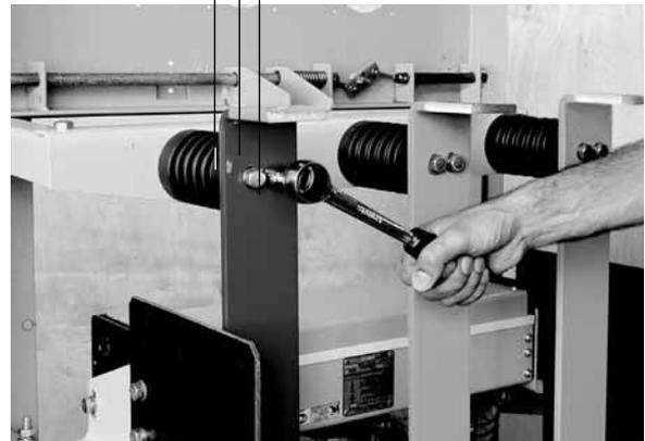
Рис.7.16 Крепление фиксаторов верхних шин ВВ/TEL 10-20/1600
