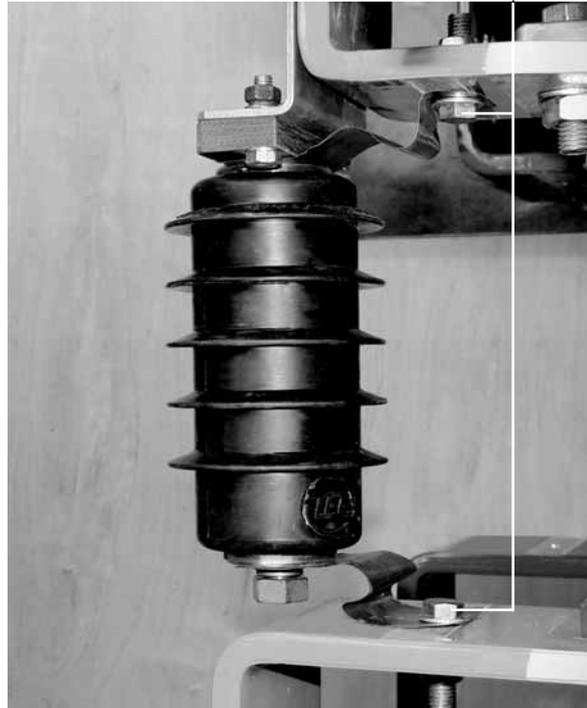
Рис.16.3 Установка ОПН в сборе с элементами крепления на ошиновку ВВ/TEL 10-20/1600
