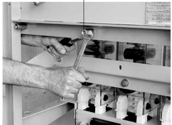
Рис. 7.11 Установка узла заземления ВВ
