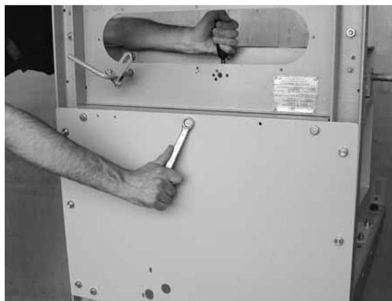
Рис.10.3 Организация прохода жгута через фасадную панель ВЭ МВ АК 10/400/8 и АК 10/800/20
