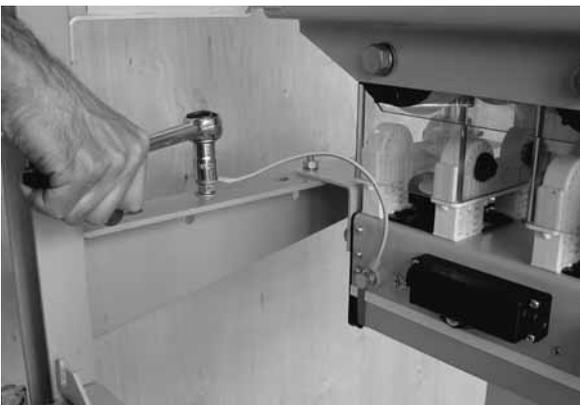
Рис. 7.12 Установка балок крепления дополнительных опорных изоляторов на ВЭ МВ АК 10/400/8 и АК 10/800/20
