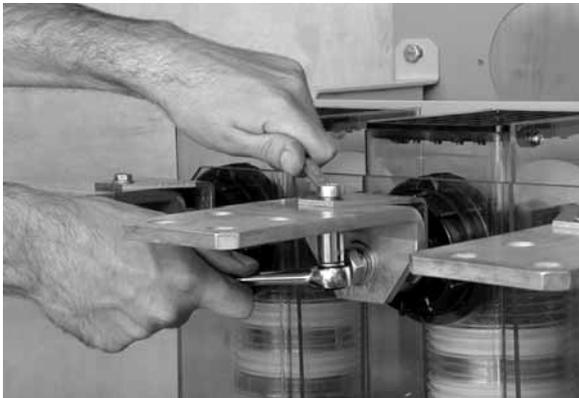
Рис. 7.17 Монтаж верхних ШПК на шинах ВВ
