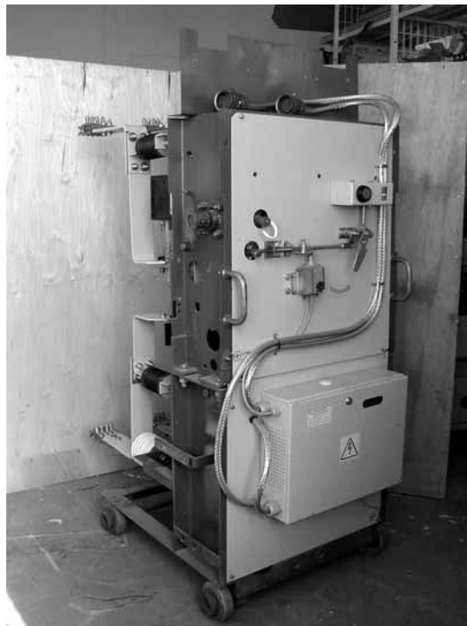
Вид с фасада
